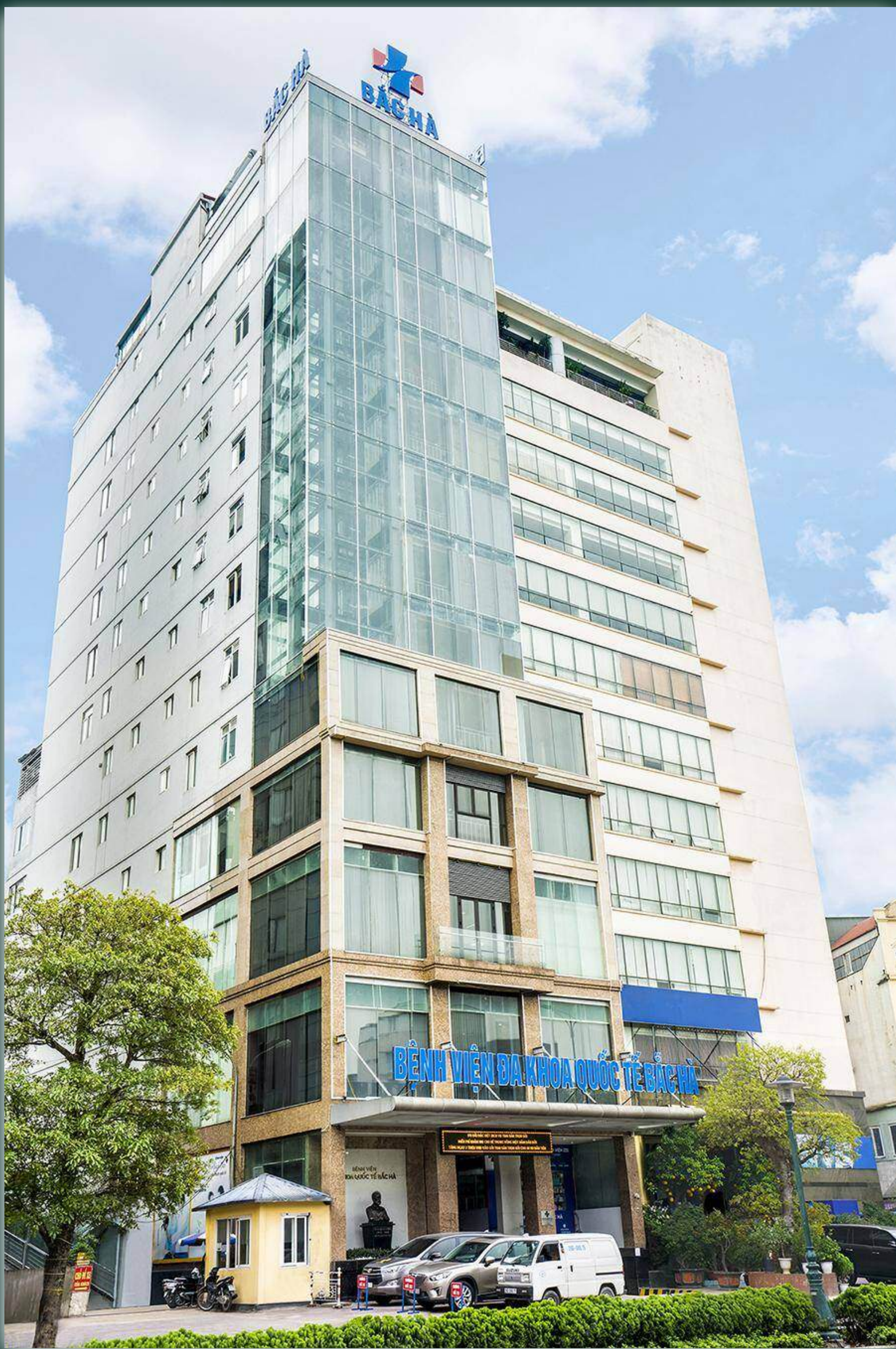
Thang Mitsubishi 14 stops – Bệnh viện Bắc Hà (Đường Nguyễn Văn Cừ, Bồ Đề, Hà Nội)
