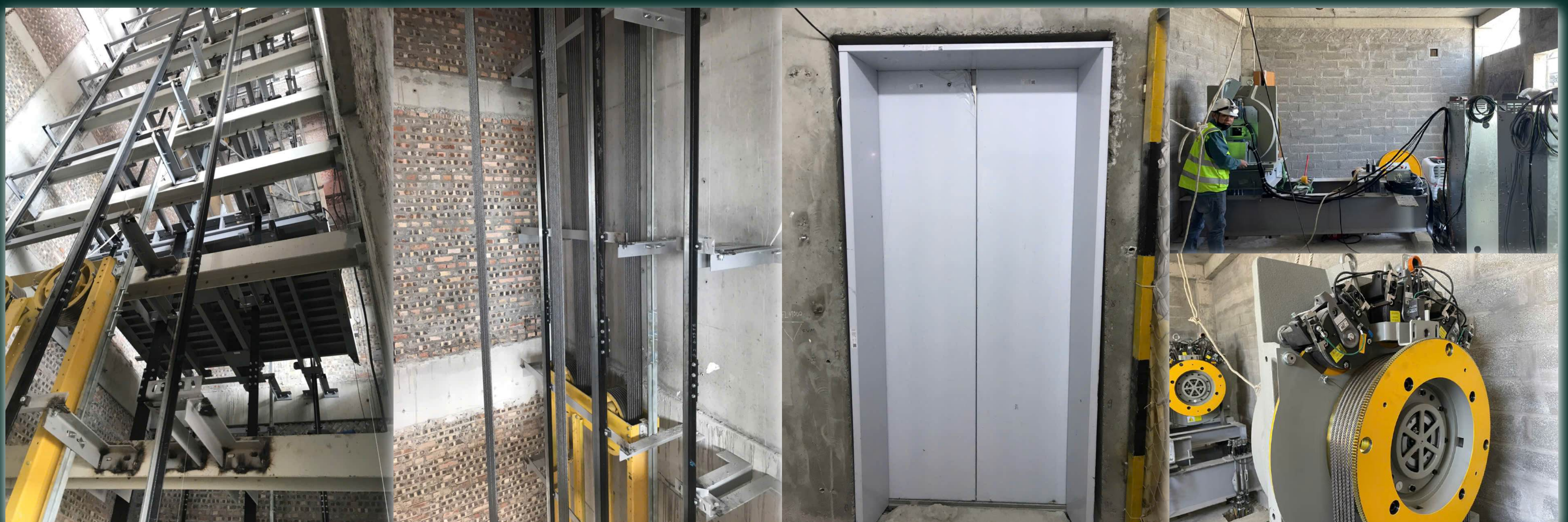
Thi công lắp đặt thang máy
